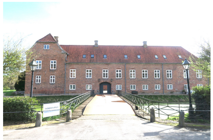
Hovedbygningen, som omkranses af vandfyldte grave, har gennemgået en større restaurering og er i dag private boliger.
