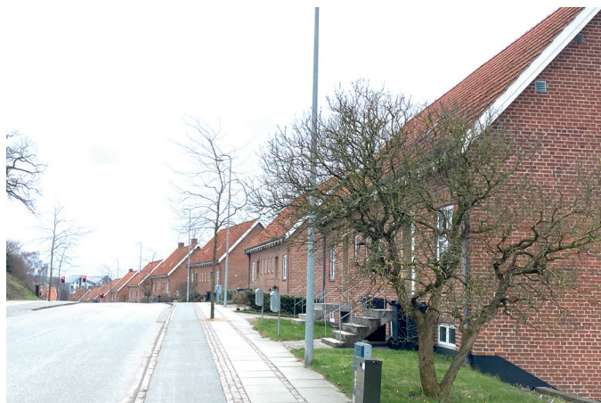
Doppelthusene er tilpasset det faldende terræn og fremtræder med et enkelt arkitektonisk udtryk med næsten ubrudte sadeltage i rødt tegl, synlige spærender, hvidmalet træværk og trapper i beton.
