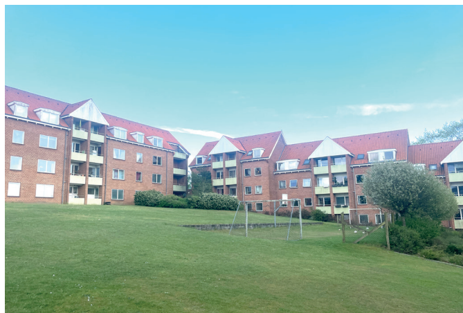
Vestervang stod før renovering med markante frontispicer med indeliggende altaner og værn i mønsterpræget beton. Blokkene i forskellige længder er organiseret omkring de fælles grønne arealer og tilpasset det stærkt stigende landskab.
