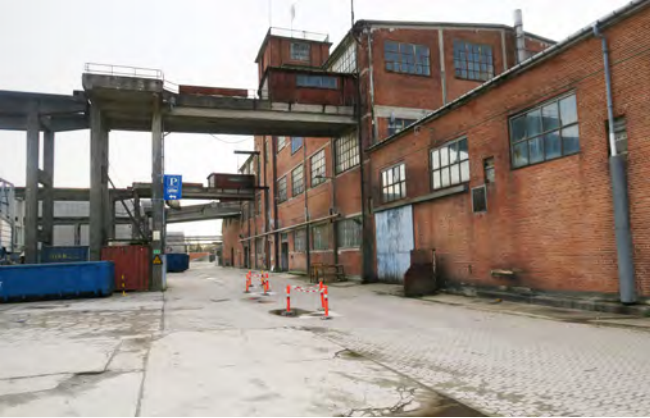
Papirmaskinehallerne med kranbroer
