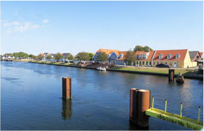
Den udgravede kanal og husrækken Ved Broen på Enø
