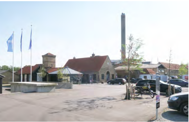
En del af det ældre, bevaringsværdige fabriksanlæg
