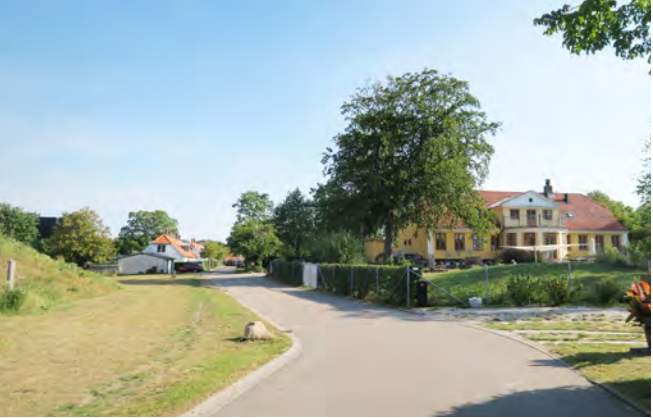
Direktørboligen til højre i billedet og arbejderboliger i baggrunden på Svinget ved ankomsten fra kirkestien
