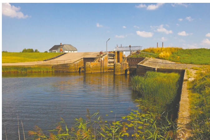
Højer sluse og dige
