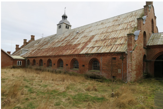
Egebaksandes massive byggeri kommer bl.a. til udtryk i denne murede udlænge med markant kamtakket gavl
