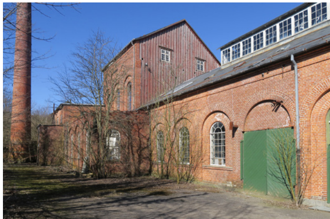
Saftstationens hovedbygning og skorsten
