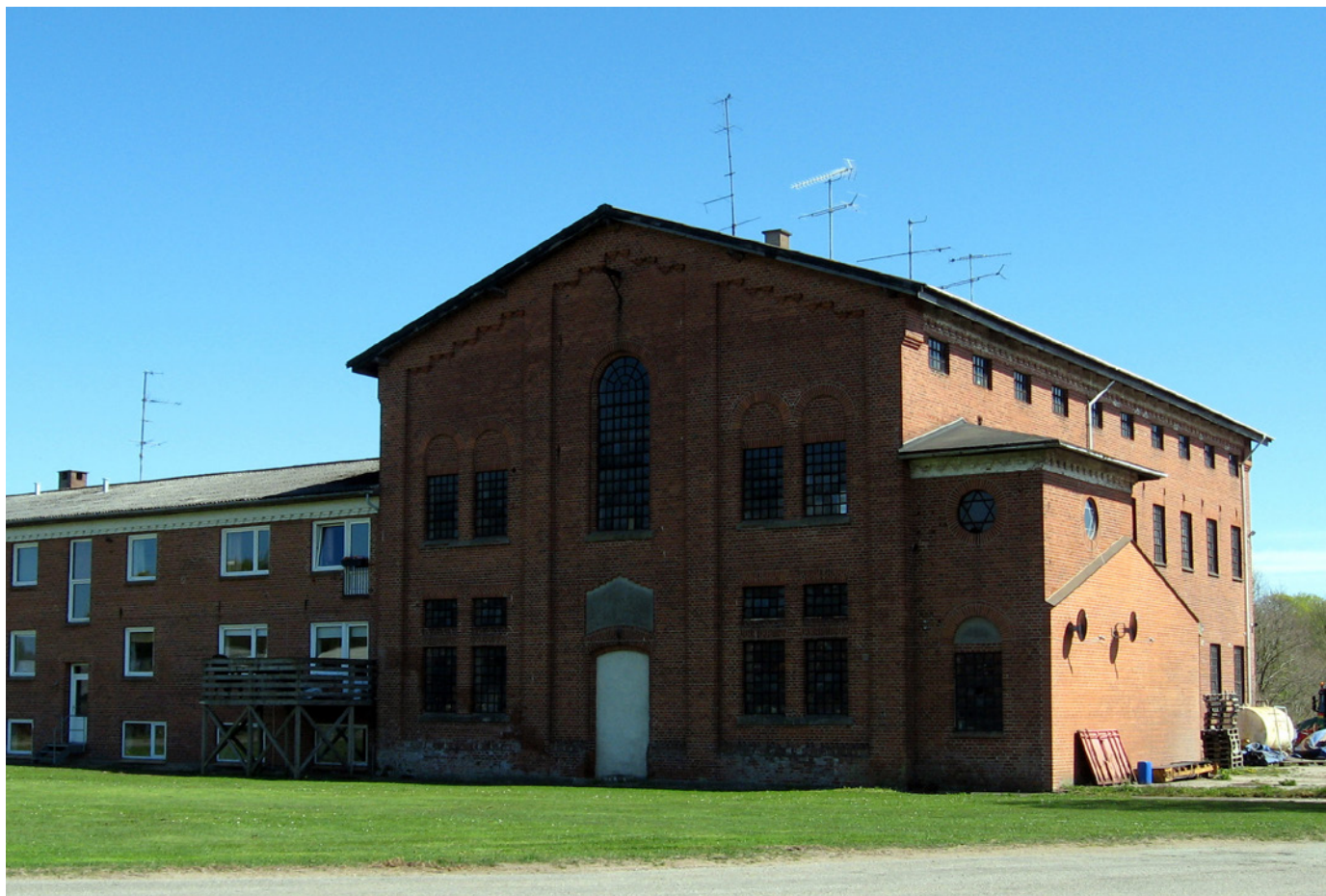
Den gamle kartoffelmøllefabrik på Anlægsvej
