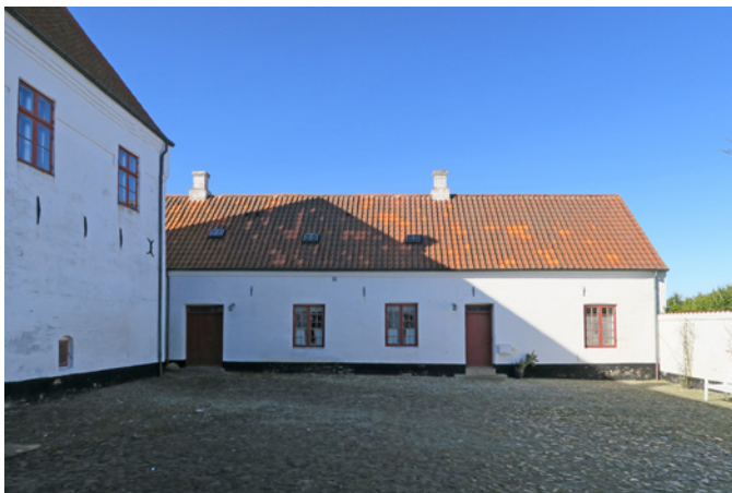
Oddens vestfløj set fra den pigstensbelagte gårdsplads
