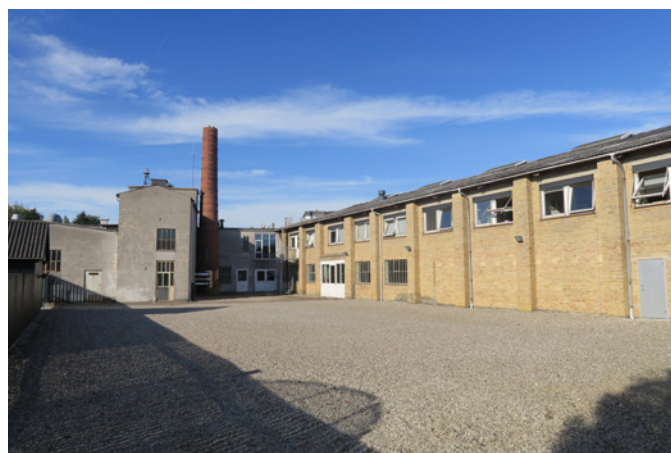
Administrationsbygningen fra 1950'erne med de gamle produktionshaller i baggrunden
