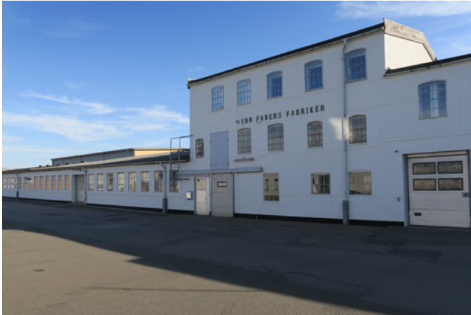
De ældst bevarede produktionshaller fra 1920'erne
