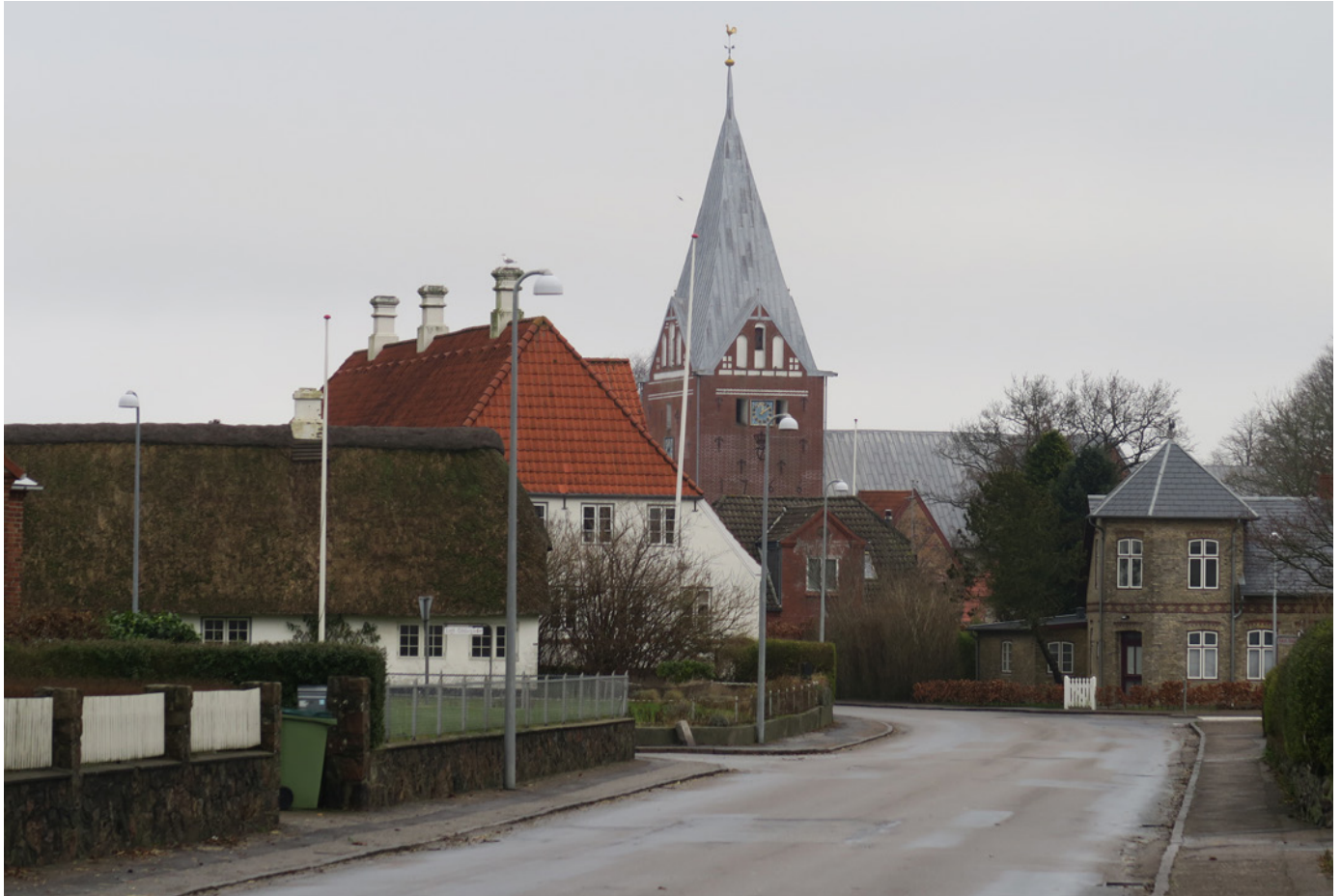
Løjt Storegade med landsbykirke og kro i baggrunden. Belægningen på gade og fortov begrænser sig til asfalt
