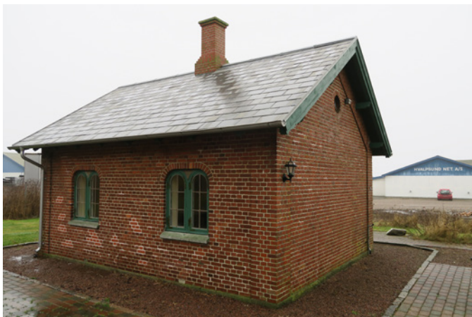
Det lille ledvogterhus og Hvalpsund Vodbinderi
