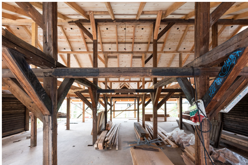
BaneGaardens ni bevarede træladar bag Hovedbanegårdens nu nedlagte jernbaneterræn revitaliseres med fokus på bæredygtighed og med en usædvanlig høj grad af bæredygtige genbrugsmaterialer. Laderne istandsættes løbende over flere år som led i en langsigtet strategi, hvor selve den håndværksmæssige byggeproces bliver en del af ladernes dna. Foto Rønnow Arkitekter
