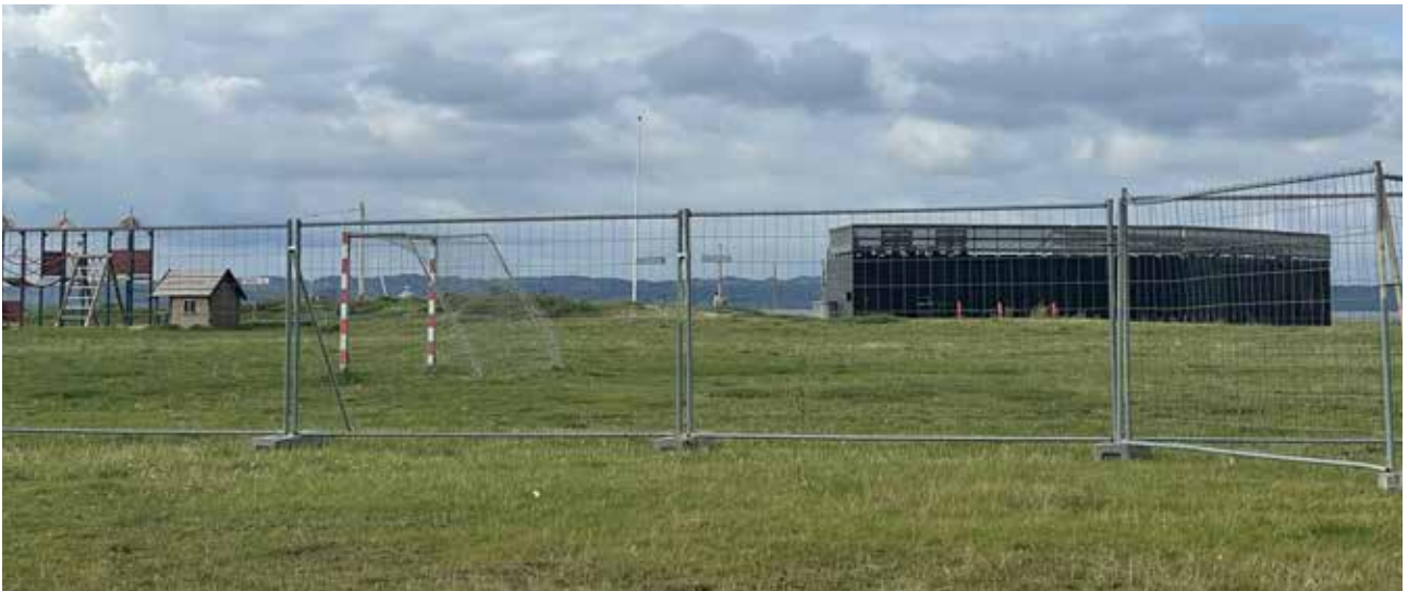
Figur 17. Byggefelt på et havneareal gøres klar til byggeri. Foto: Katrina Wiberg.
