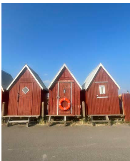
Velkendte robuste typologier der er hævet over jorden. Funktionerne er ikke sårbare og byggepraksis er fleksibel, da bygværkerne kan flyttes relativt nemt.
